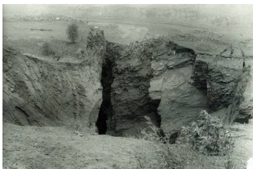
Рис.1. Воронка-провал на восточном борту карьера ЦГОКа, образовавшаяся 08.07.1982 г. по 78 оси ш. "Октябрьская"
