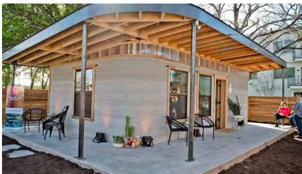
Рис.13. Житловий будинок пл. 60 м 2 компанії ICON збудований методом 3D-друку
