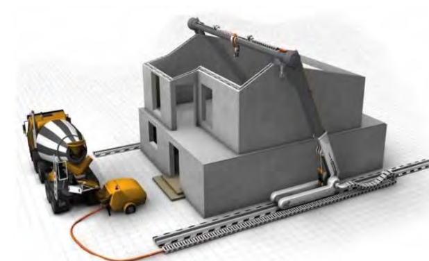
Рис.12. Технологія зведення двоповерхового житлового будинку методом 3D-друку
