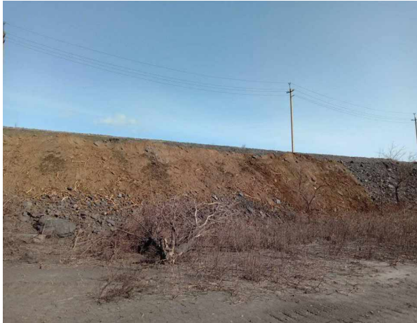
Рис. 6. Мулові осадки на зовнішній частині ярусу хвостосховища
