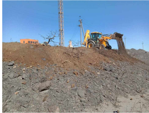
Рис. 7. Процес нанесення мулових осадків
